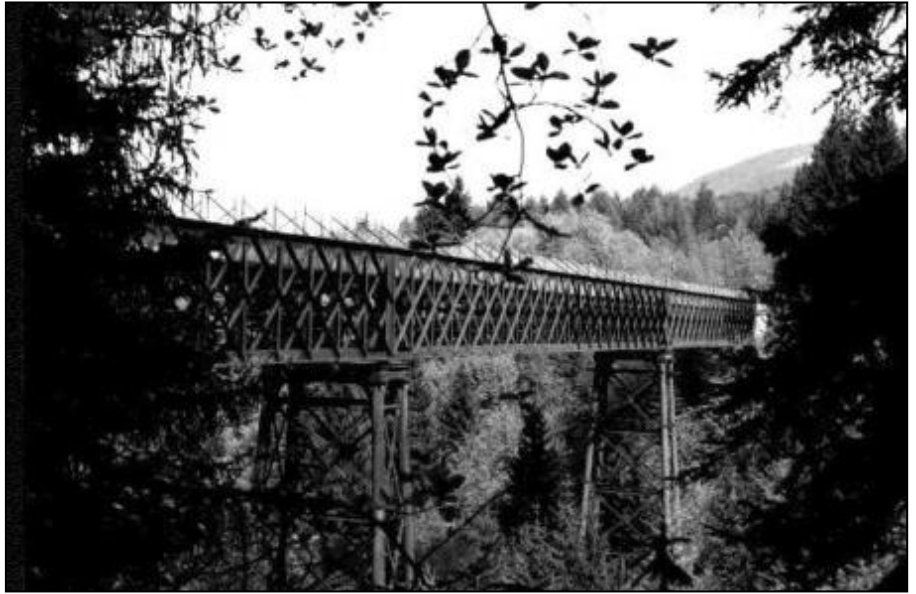
Il viadotto sul Rio Bianco nel 1987 (foto C. Canton)
