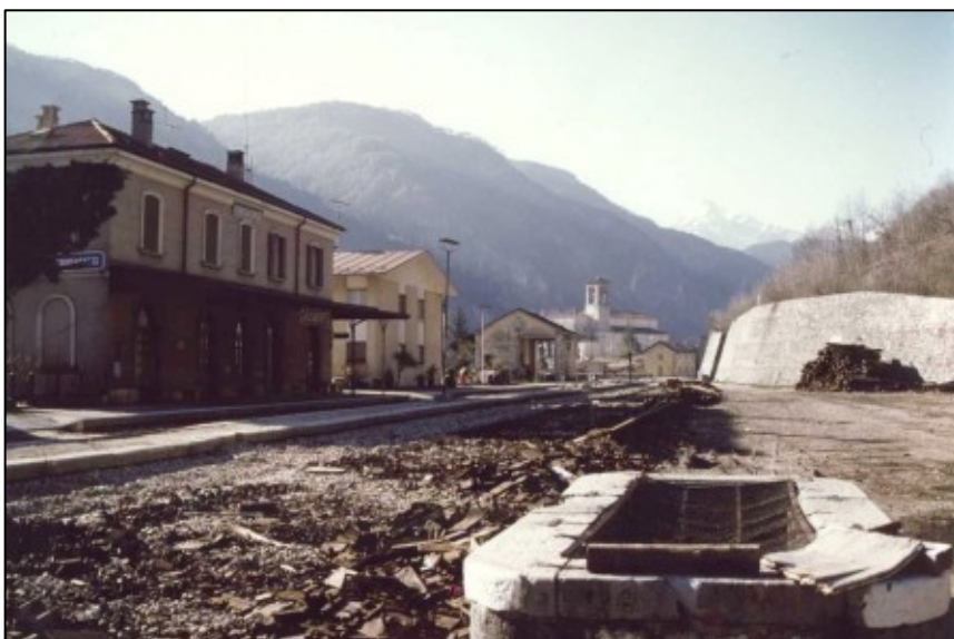
La stazione di Chiusaforte durante i lavori di smantellamento della linea nell'autunno 1995 (foto R. Chiandussi)
