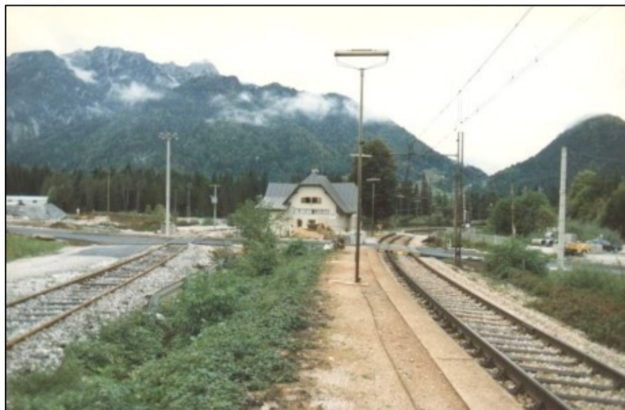
La stazione di Valbruna inserita tra la vecchia ferrovia a destra ed il binario di raccordo costruito per i lavori sulla nuova linea. 26 settembre 1993 (foto C. Canton)
